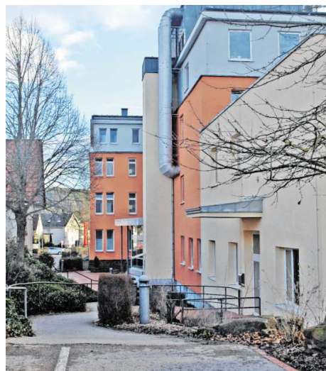
An dieser Stelle am Hardheimer Krankenhaus soll der Anbau mit weiteren Behandlungsräumen entstehen.
