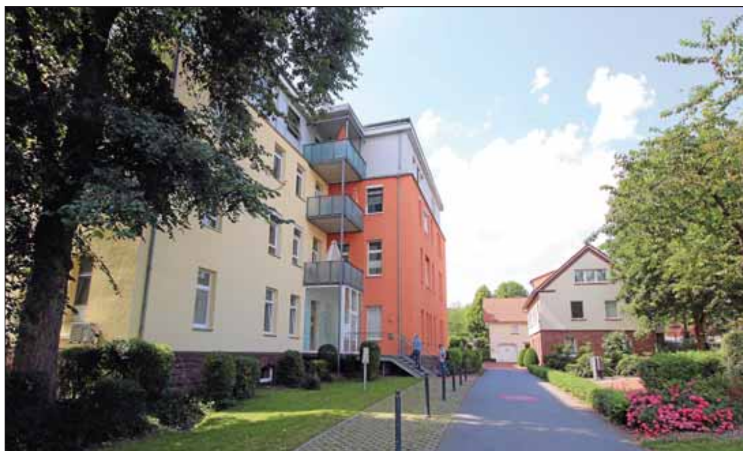
Das Erscheinungsbild des Hardheimer Krankenhauses wird sich durch die Baumaßnahme verändern: Auf der Freifläche vor der internistischen Praxis entsteht für 2,3 Millionen Euro ein Anbau. Baubeginn soll im April sein. Fotos: Rüdiger Busch/Krankenhausverband
