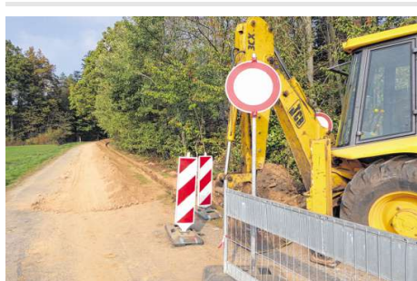
Die Wolfsgrubenhütte erhält einen neuen Wasseranschluss. Aus diesem Grund ist derzeit der Waldweg vom Wanderparkplatz aus gesperrt.
