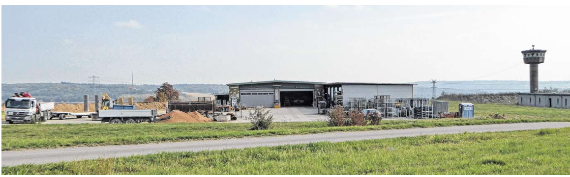
Die Firma Hollerbach erweitert eine Unterstellhalle auf dem firmeneigenen Gelände der ehemaligen Nike-Stellung, nachdem im Materiallager derzeit noch keine zivile Nachnutzung möglich ist.
