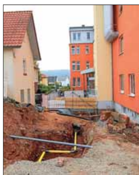
Die vorbereitenden Arbeiten für den Umbau laufen bereits auf Hochtouren.
