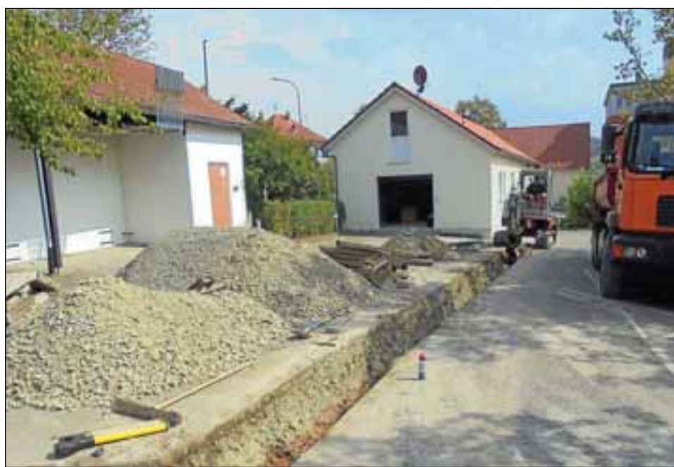
Mit der Neuverlegung von Leitungen sind die Arbeiten am Krankenhaus gestartet.
