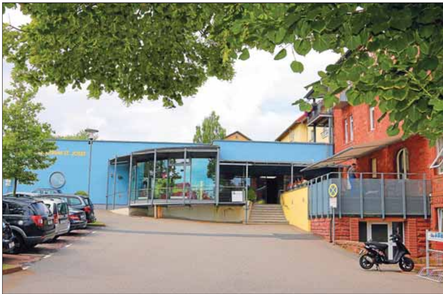
Umfangreiche Umbaumaßnahmen sind am Geriatrizentrum „St. Josef“ in Walldürn geplant. Die Fertigstellung des 5,5 Millionen Euro teuren Umbaus soll bereits im Sommer 2019 gefeiert werden. Archivfoto: Rüdiger Busch
